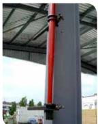
• База в виде кронштейна для двутавровой балки База состоит из связки двух балочных кронштейнов и специального стакана.
